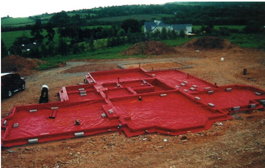
Joonis 4. Radoonitõkkekile paigaldamine (Ehitusteave, 2006).
