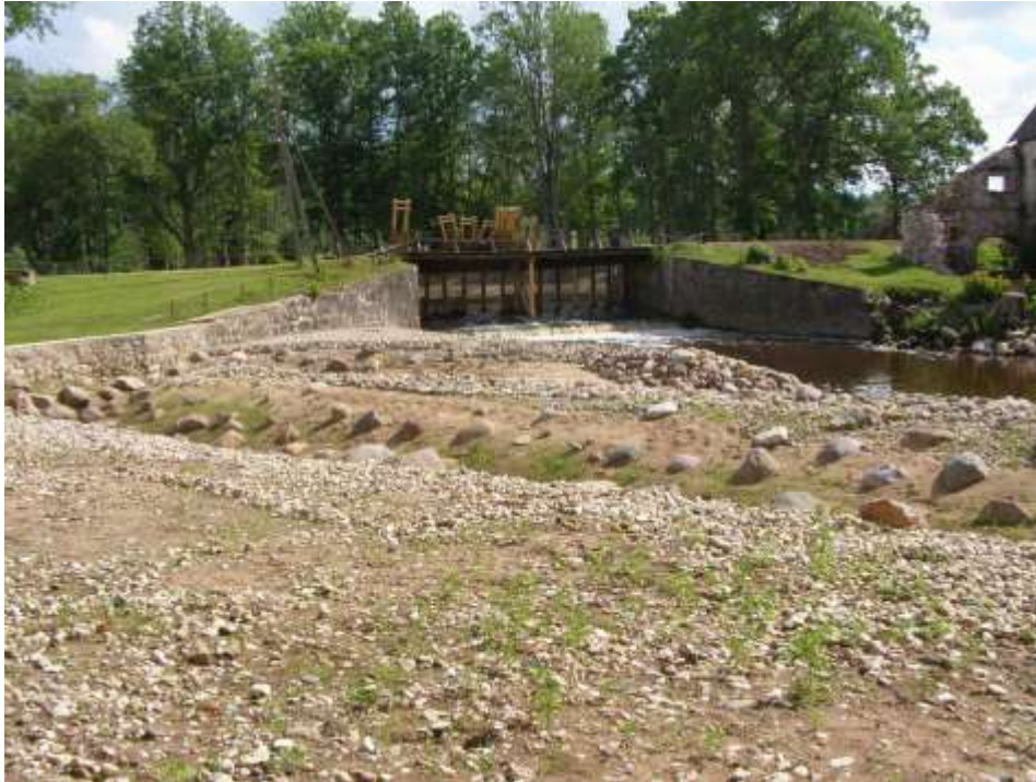
Foto 3. Vastse-Roosa pais ja kalapääs. Pais on alla lastud ning kalapääsu kaudu vesi ei voola (16.06.2013).
