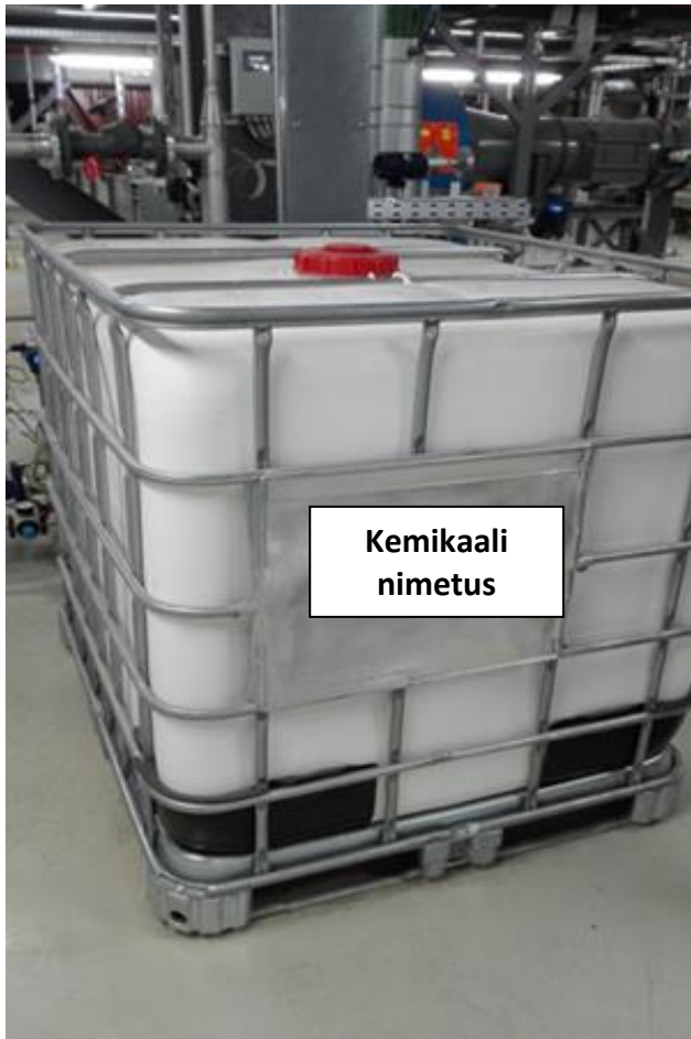
Foto 3. Kemikaali Z hoiustamine 1 m 3 -lises PVC mahutis betoneeritud põrandal. Põrandal puudub ühendus kanalisatsiooniga.
