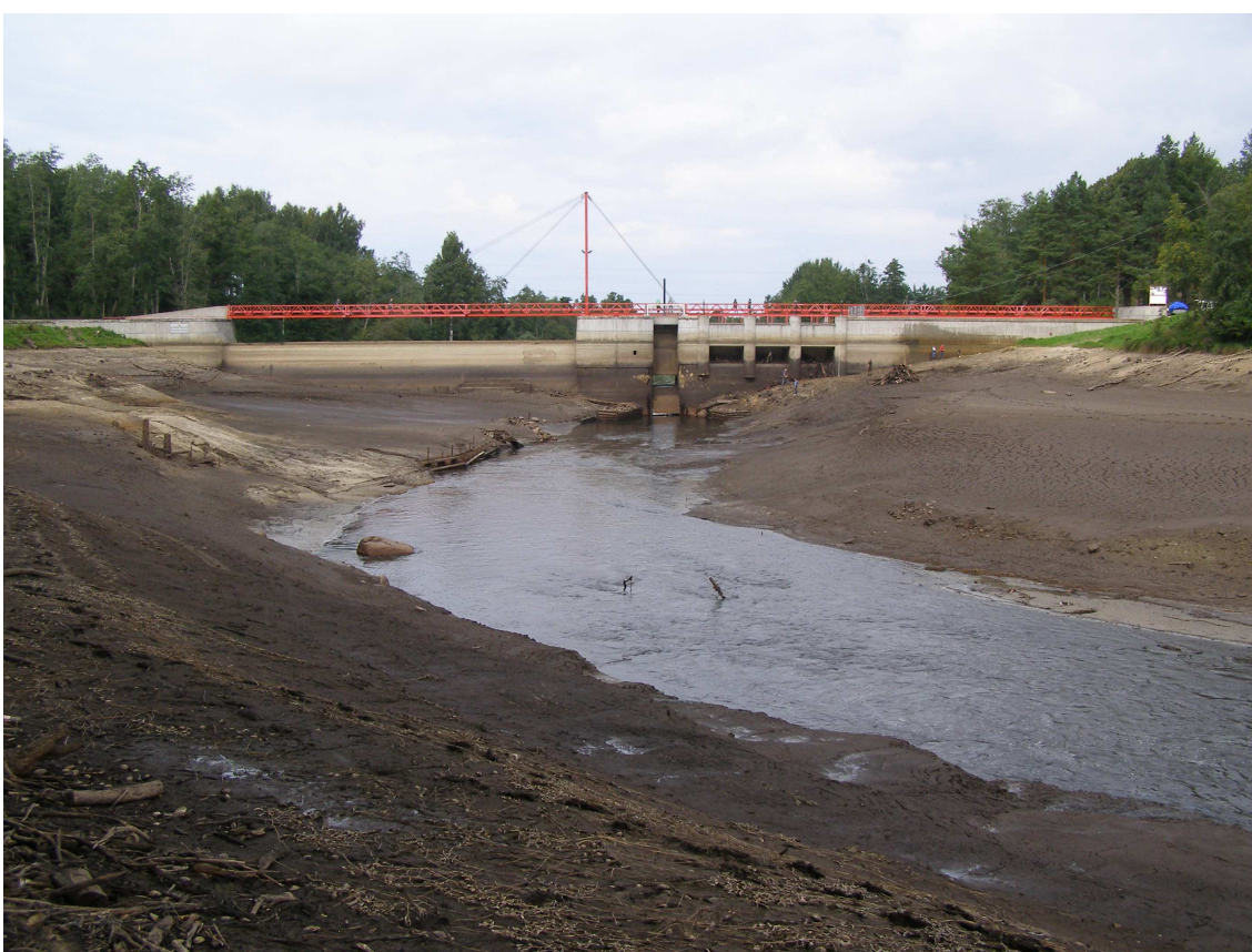
Foto 3, 4, 5, 6. Vaade paisu konstruktsioonidele ülavee poolt tühjaks lastud paisjärve korral 22.08.2011
