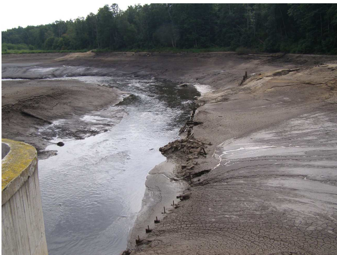
Foto 7, 8. Vaade ülavee poolsele voolusängile tühjaks lastud paisjärve korral 22.08.2011
