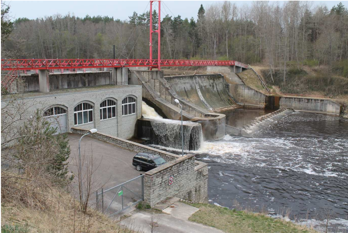
Foto 1. Vaade Linnamäe hüdroelektrijaama paisule alavee poolt paremalt kaldalt 25.04.2019
