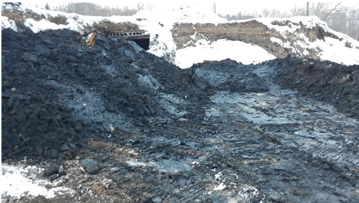
Pilt 2. Väljakaevatud reostunud pinnas
