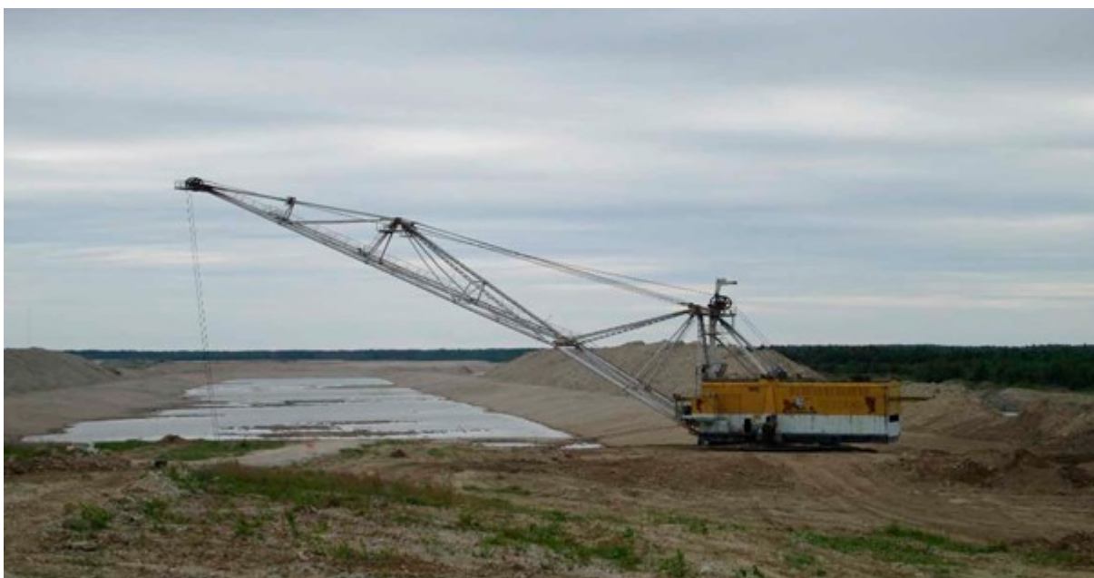
Aidu karjääri korrastamise käigus sõudekanali kaevamine Foto: Tiit Rahe
